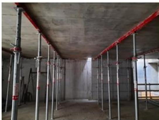
**Figura 1.** *Proceso de cimbrado, clareado y descimbrado. Fuente: [2]*
