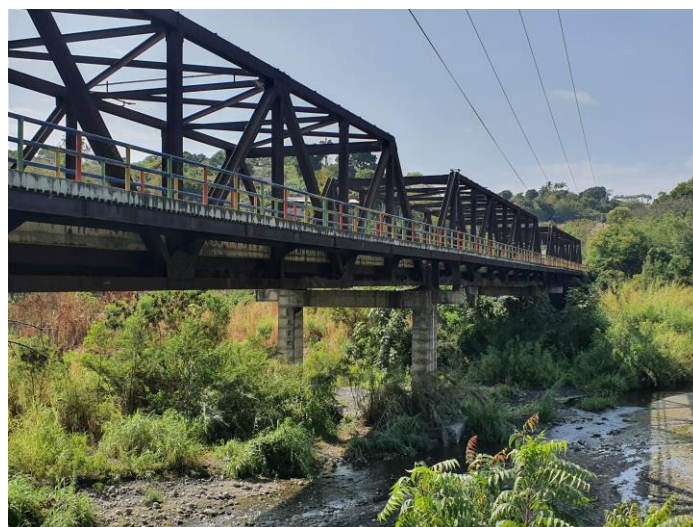
Figura 1. Superestructura de un puente de armadura. Fuente: [11]
