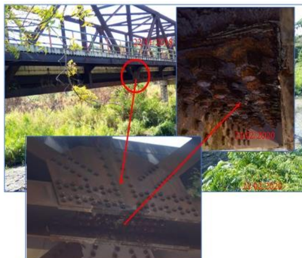
Figura 4. Estado de la unión de la armadura con el tablero. Fuente: los autores
