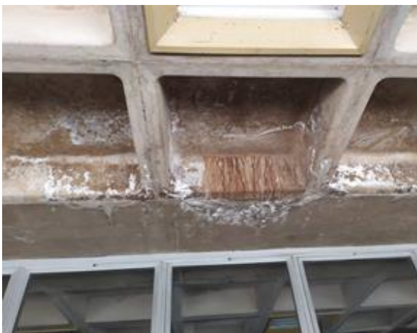
Figura 7. Manchas blancas y sangrado en losa reticular. Fuente: los autores
