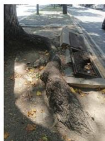
Daños Severos Daño estructural en la tanquilla Av. Leones
