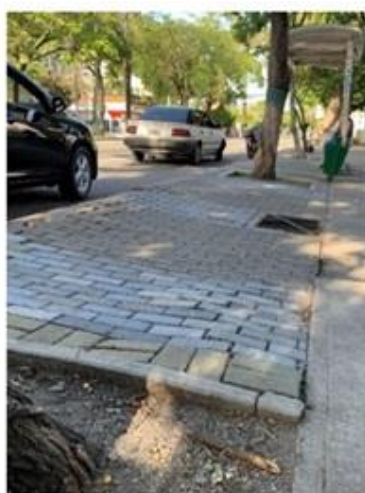
Daños Leves Deformación del pavimento articulado Av. Lara
