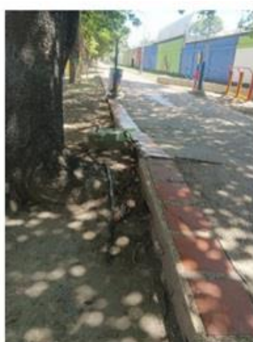
Daños Moderados Elevación de la infraestructura peatonal Av. Leones
