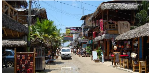
Ilustración 5. Daños en la infraestructura vial
