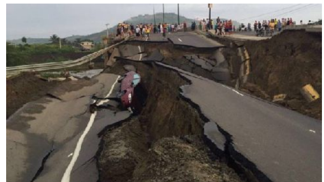
Ilustración 3. Daños en la infraestructura vial
