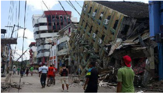
Ilustración 4. Colapso de edificaciones
